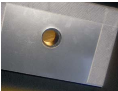
BU: Ein Qasa-Sandwichelement mit vorgeplantem Durchbruch.
