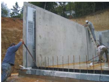
BU: Ein Qasa-Element im Einsatz: Hier als mittige Dämmung der vorgefertigten Betonaußenwand im Untergeschoss (Bauteiltyp 330). Durch die äußerst robuste Schutzhülle sind bauübliche Beschädigungen an den Dämmelementen ausgeschlossen.
